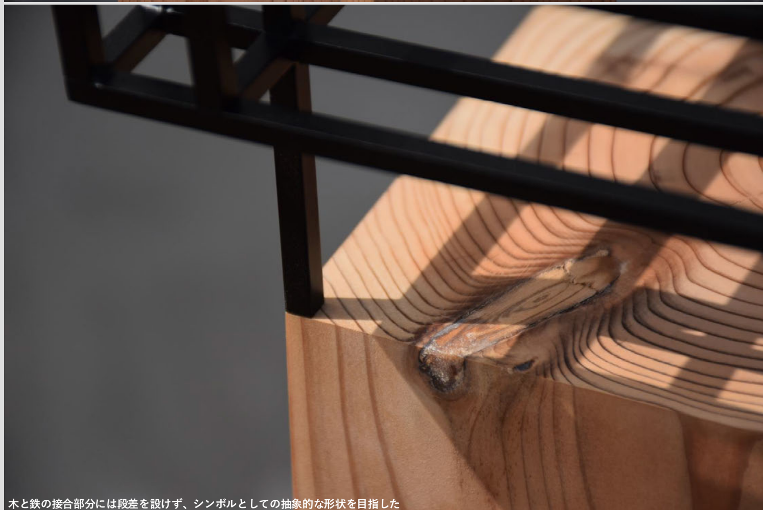
神戸の地場材である杉材、「裏六甲」と呼ばれる寒冷地から採られたため硬度が高く、精度の高い形状を実現させることができた
